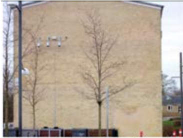
Tingbjerg, overfor Lille Torv: Blind gavle og massiv dækning med overvågningskameraer.
