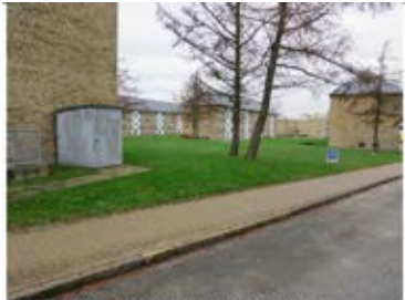
Husum, Voldparken: Mange blinde gavle.
